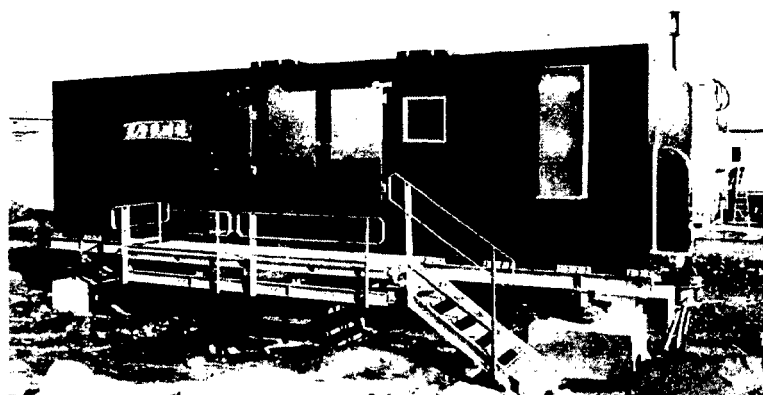
写真 III.2.3-2 42 次夏期オペレーションで建設された光学観測棟。建物の東側より撮影した。背後に情報処理棟がある。出入口の右側にある2枚のステンレス製扉は将来設置予定のミリ波分光観測用の窓である。天井にはFPI観測用天窓の他に4カ所の開口部があらかじめ作ってある。
