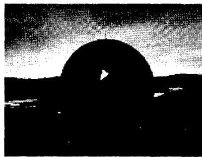
写真Ⅲ.3.7.1-2 補修後のレドーム
