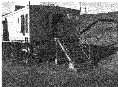
写真Ⅲ. 3. 6. 1-9 ラック搬出状況 1
