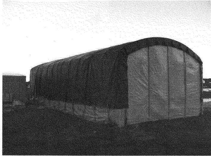
写真Ⅱ.3.3.12-1 補強シート『パラウエブマット』設置完了
