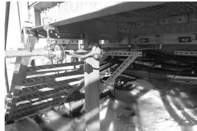
写真Ⅲ.4.1.3-6 棟側配管サポート設置状況
