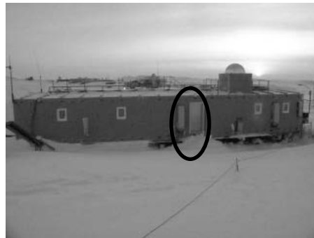
写真Ⅲ. 4. 6. 1-2 (新設された非常口)
