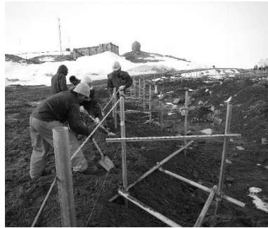
写真Ⅲ. 4. 1. 5-2 サポート設置状況
