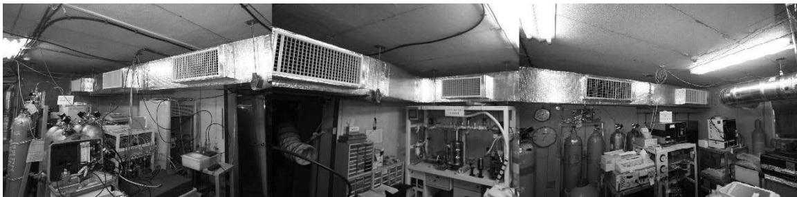
写真Ⅲ.4.1.29-2 ダクト設置状況
