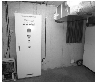
写真Ⅲ. 4. 1. 29-6 盤設置状況
