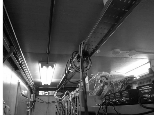
写真Ⅲ.3.2.1.1.3-1 追加した電源ユニット（下段）と電源線（青線）
