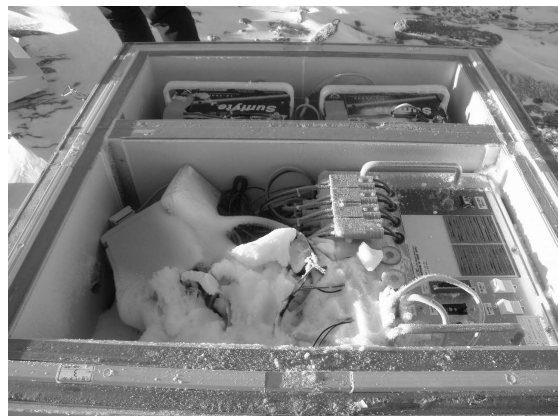
写真Ⅲ.3.2.4.1.6-2 風発システムへの雪の吹込み
