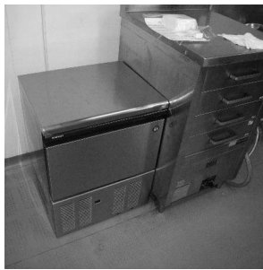
写真Ⅲ.4.1.28-1 製氷機設置状況
