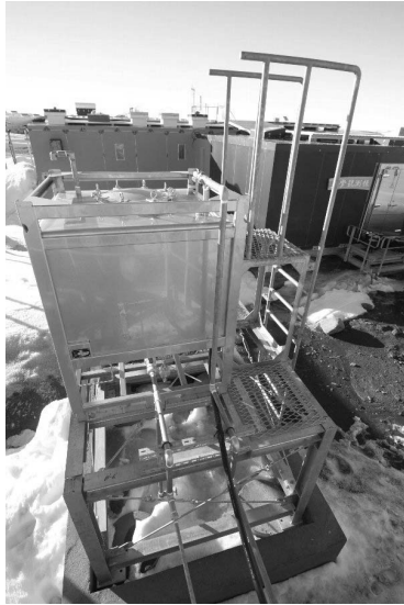
写真Ⅲ.4.1.3-3 架台・燃料タンク設置状況
