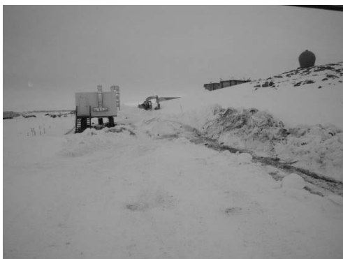
a) 予備食冷凍庫側
