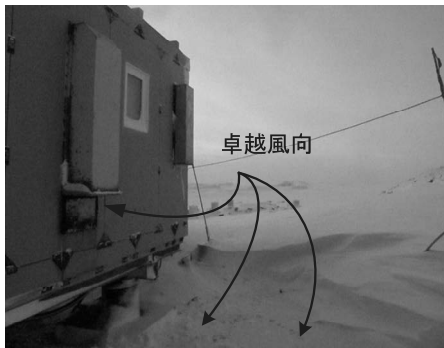
写真Ⅲ. 4. 6. 1-3 改修前のダクト
