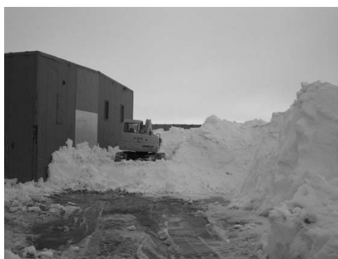
写真Ⅲ.6.4-7 倉庫棟（中盤）
