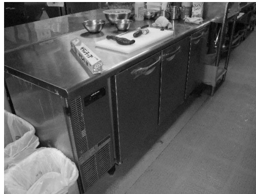
写真Ⅲ.4.1.28-4 コールドテーブル設置状況
