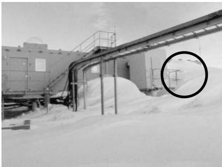
写真Ⅲ. 4. 6. 1-1 (衛星受信棟のドリフト)
