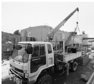
写真Ⅲ.4.1.3-1 燃料タンク設置状況
