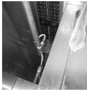
写真Ⅲ.4.1.28-2 給水管設置状況
