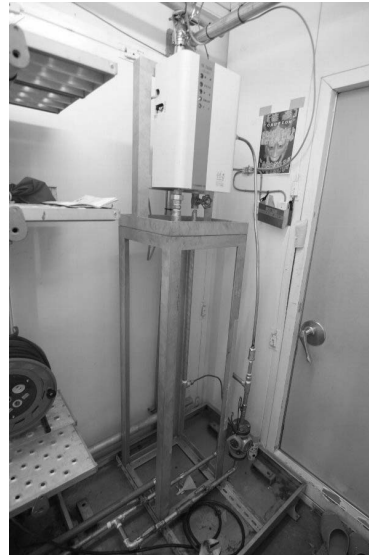
写真Ⅲ.4.1.3-4 オイルキャリア設置状況
