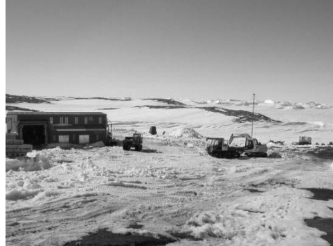
写真Ⅲ. 6. 4-13 終盤の様子
