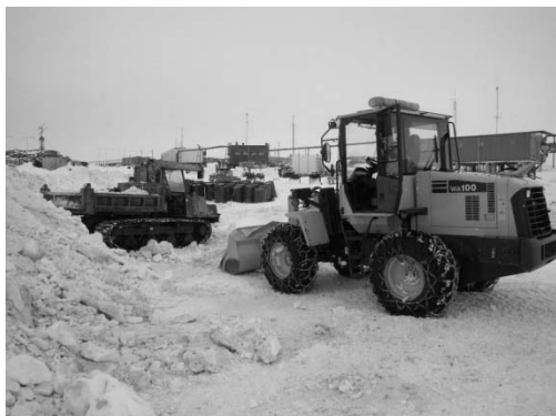
写真Ⅲ.6.4-6 居住棟前（序盤）
