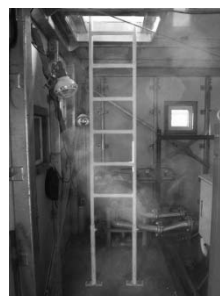
写真 4.8.2-2 扉部小屋内部
