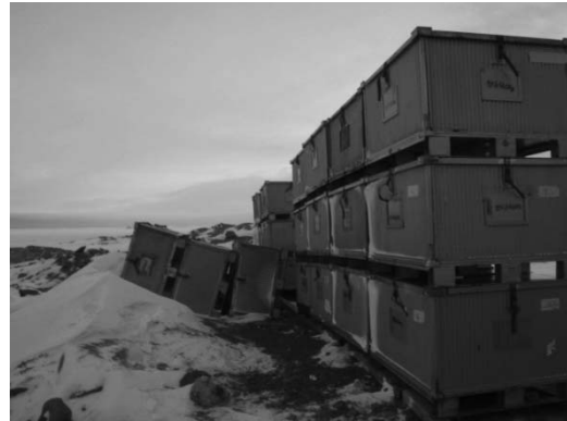
写真Ⅲ.4.5.10-4 スチールコンテナ倒壊
