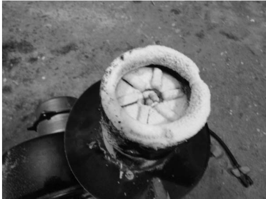
写真Ⅲ.4.5.8-1 脱臭バーナー失火後の分解整備
