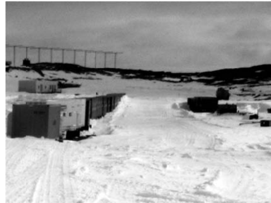
写真Ⅲ.6.3-6 コンテナヤード裏の積雪状態
