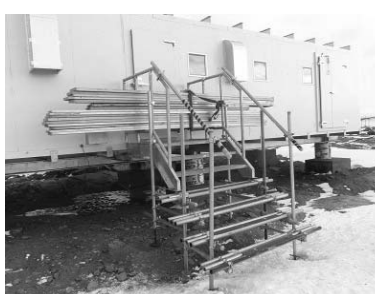
写真 4.8.1-4 階段設置後
