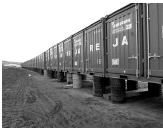
写真Ⅲ.6.3-1 12ft コンテナ嵩上げ状態
