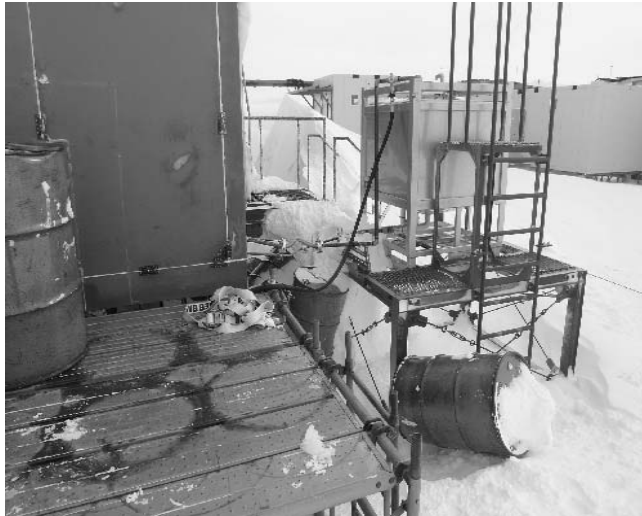
写真Ⅲ. 6.2.4-1 ドラム缶置き場と屋外タンクの位置関係および飛散したドラム缶
