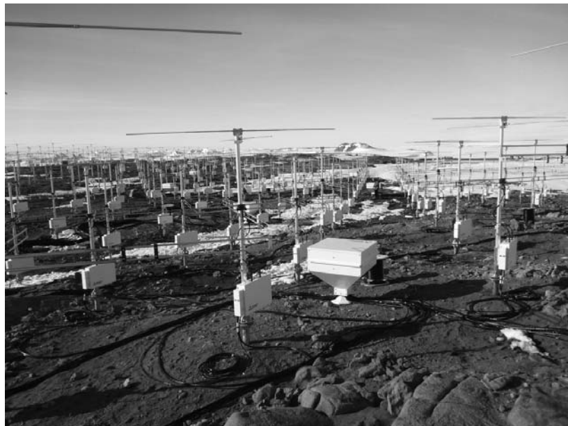
写真 II. 2. 1. 1-1 送受信モジュールを設置したアンテナ群
