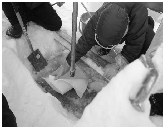
写真Ⅲ. 6.2.4-4 防油堤の底の漏油を吸油シートで除去する
