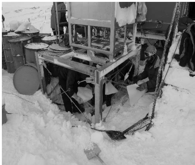
写真Ⅲ. 6.2.4-5 タンク周辺の汚染雪を取り除く
