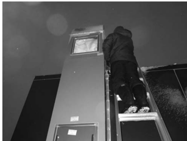
写真Ⅲ.3.2.1.1.2-3 吸気ダクト内部着雪の除去作業。扉取り外しが危険。(6/1撮影)
