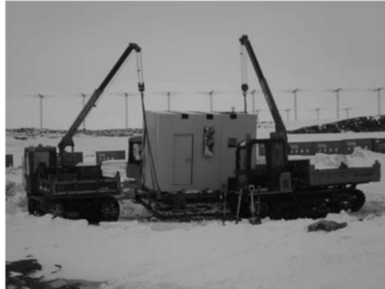
クレーンで2本吊りされソリ上に設置された（右）
