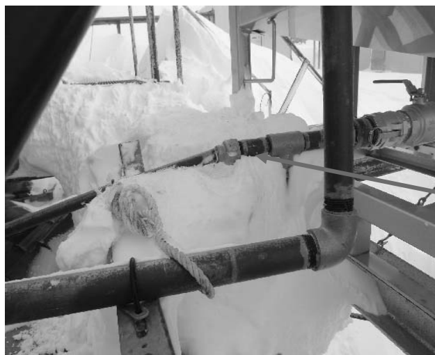
写真Ⅲ. 6.2.4-2 亀裂の入った給油配管
