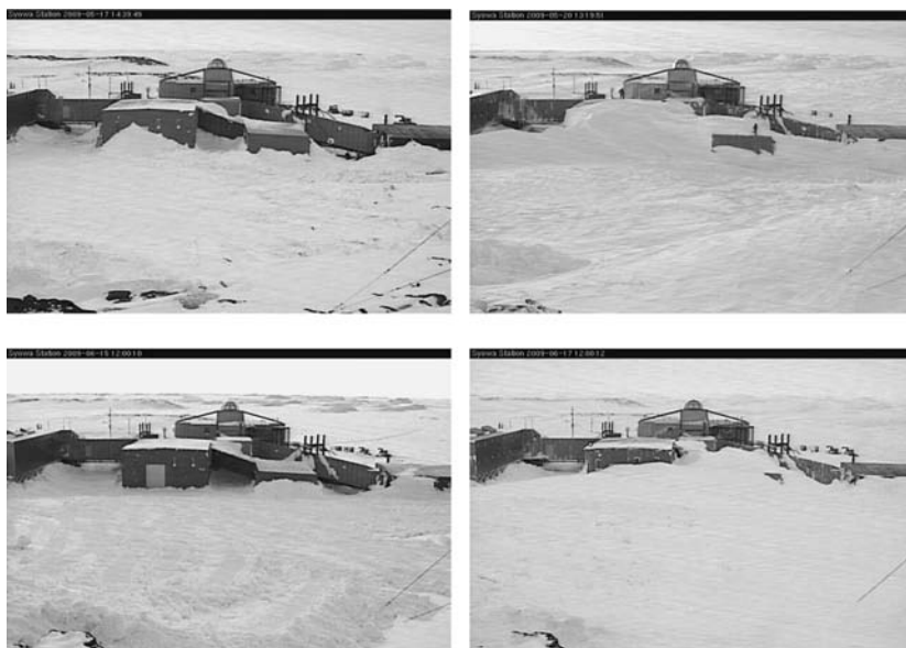
図 17 管理棟風下側のブリザード前後の積雪量比較。 (上) ブリザード前: 5月17日, ブリザード後: 5月20日, (下) ブリザード前: 6月15日, ブリザード後: 6月17日
