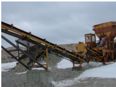
Photo 23 コンクリート骨材用岩石破砕機
