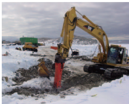
Photo 25 Thala valley の廃棄物埋め立て地の掘削現場
