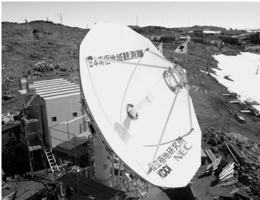
図 9 アンテナ組立て完成写真。主反射鏡直径 7.6 mφ
