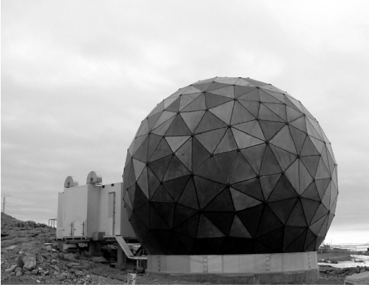
図 8 アンテナレドーム完成写真。レドーム直径 11 m、高さ 9.8 m (基礎部含まず)。左手にはシェルターが見える。
