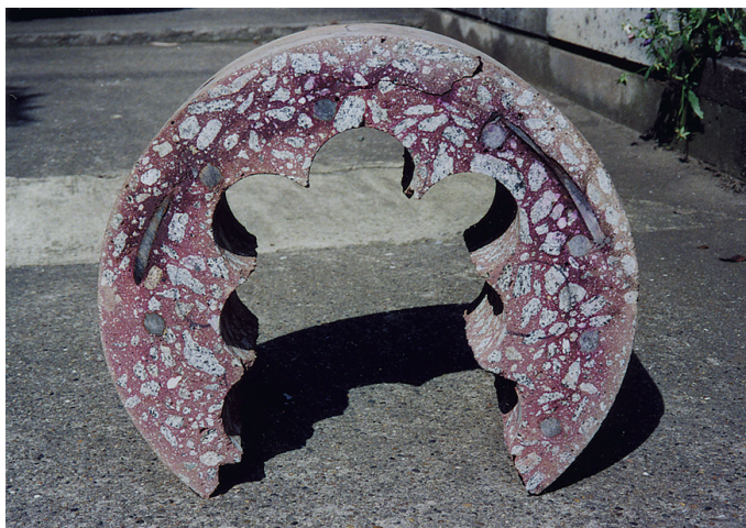
図7 コア抜き後のコンクリートピア
