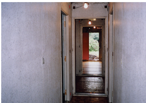
図19 室内パネルの仕上げ塗装の状況 部分的な汚れが見られたがおおむね健全な状態であった。
