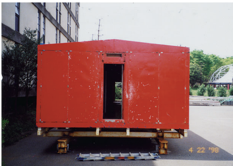
図17 建物風下，南側壁面の損傷状況。風下壁面でも外装鋼板の塗装剥離（白い斑点）が観察された。
