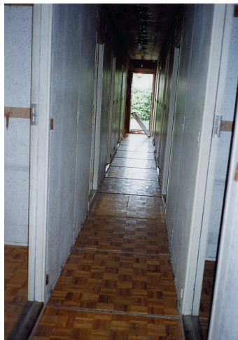
図 24 室内、床仕上げのパーケットフロア (1) 外気の影響が少ない中廊下の床仕上げはほぼ健全であった。
