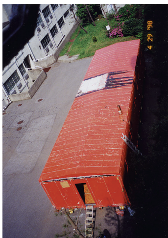
図 21 屋根パネルの状況 図の左下から右上に向かう方向が卓越風向で、右端に見える煙突の下に暖房機室がある。屋根中央の黒い部分は越冬隊員がタールを塗布して防水処置を試みた個所である。
