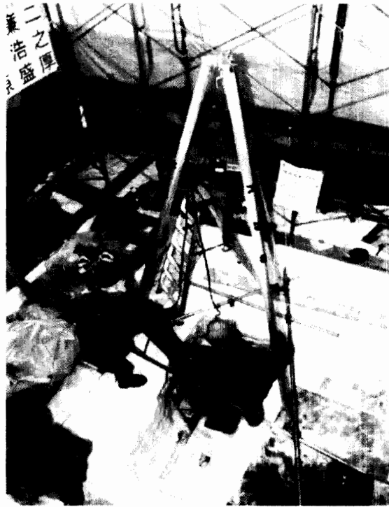
図 16 パイロット孔のリーミング作業 Fig. 16. Reaming work of a pilot borehole.
