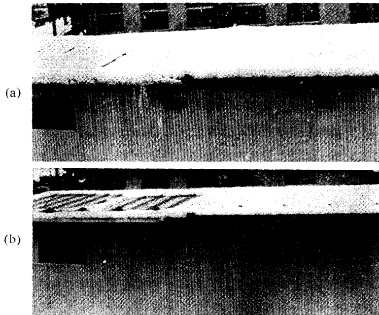
図 14 実験棟における融雪の実例
