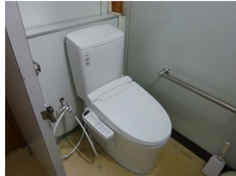
図 III.93 大便器 (INAX 製 BC-ZA10AH、シャワートイレ CW-KB21)
