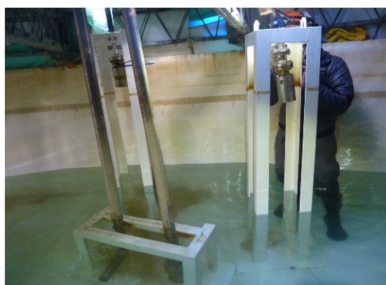
図 III.86 定水位弁交換
