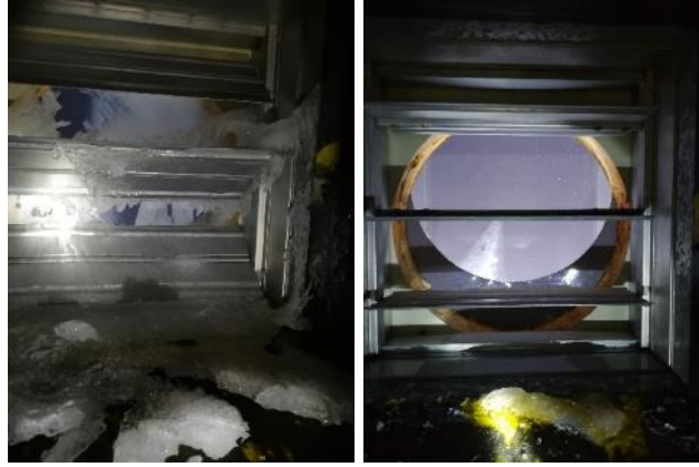
図 III.39 ダンパーへの氷付着（左：除氷前、右：除氷後）
