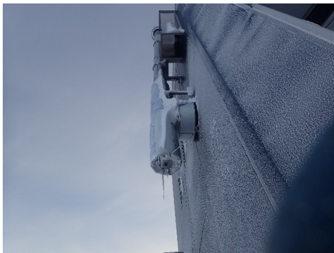
図 III.75 ボイラー排気ダクト（下面撤去前）
