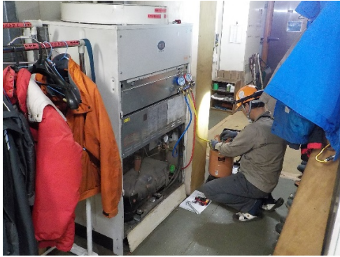
図 III.73 冷媒ガス充填作業
