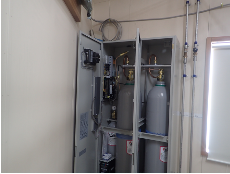
図 III.100 ポンプユニット設置
