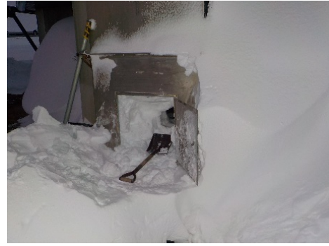
図 III.65 プリザード後に雪が吹き込んだ外調機外気取込フード
