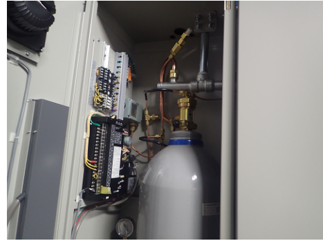
図 III.101 銅配管のポンペ庫内施工
