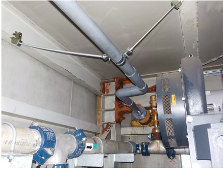
図 III.90 汚水塩ビ配管補修
