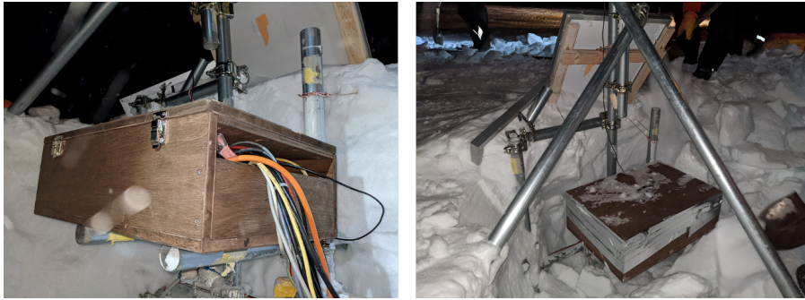
図 III.53 S17 に設置されている AWS の作業後の埋設状況
