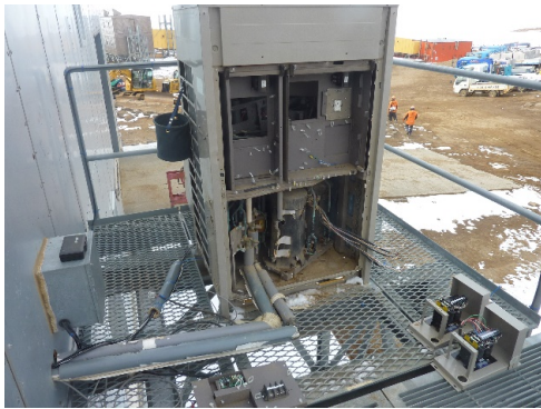
図 III.79 室外機 (撤去前)
