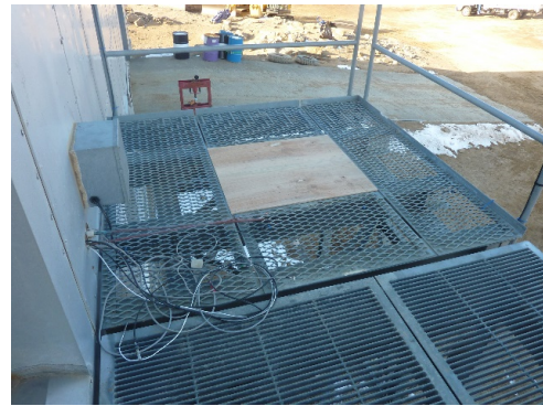
図 III.80 室外機 (撤去後)
