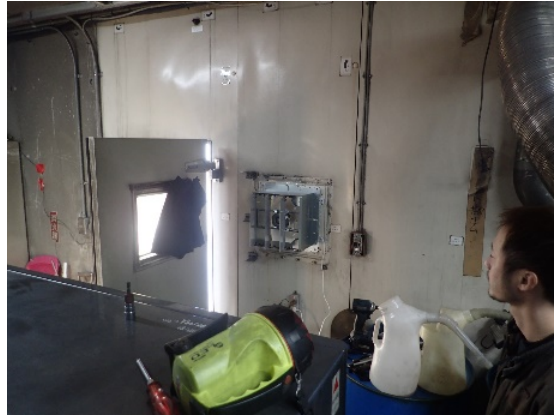
図 III.81 排気ファン（有圧扇；三菱製 EFG-25MSB）
