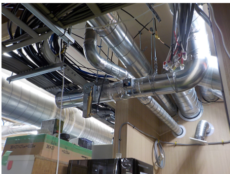
図 III.104 銅配管空調ダクト接続
