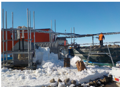
図 III.84 荒金ダム架台 (水槽側)
