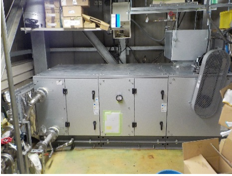
図 III.64 交換した外調機
