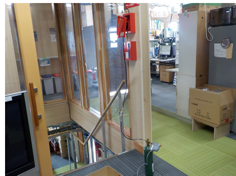
図 III.105 銅配管空圧試験
