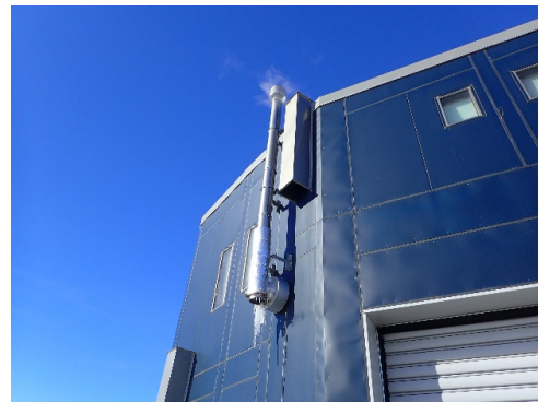
図 III.76 ボイラー排気ダクト（下面撤去後）
