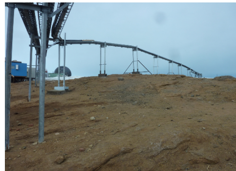
図 III.83 荒金ダム架台（中間部）
