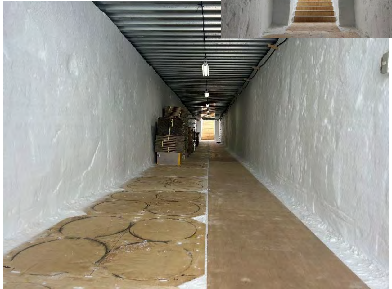
最終貯蔵庫屋内(完成時)
