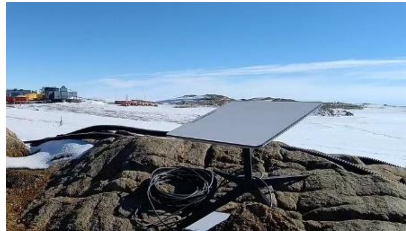
南極でのStarlinkアンテナ設置の様子
