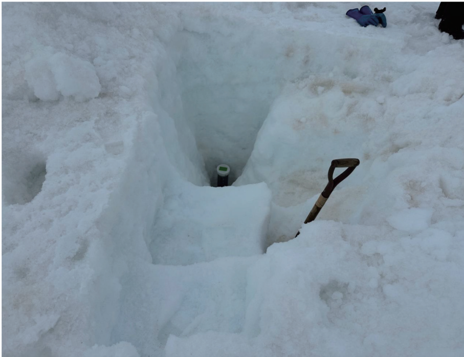
図 9 通信ペネトレータを雪面下に設置する様子.
