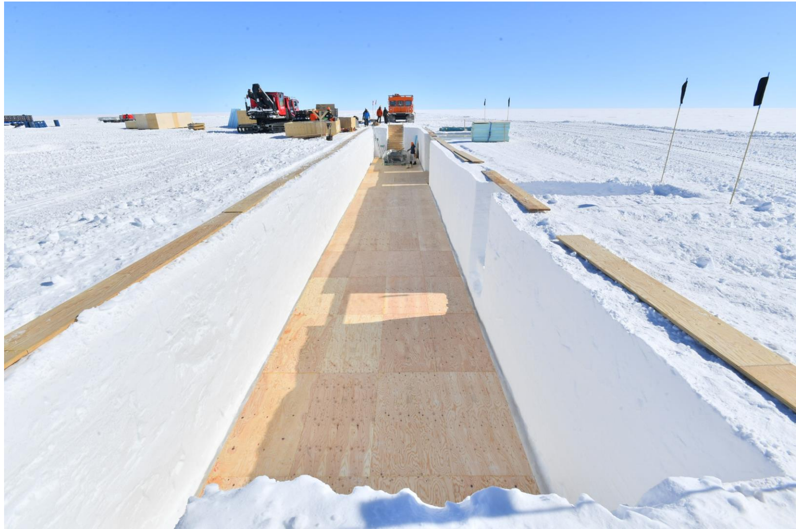
雪洞（トレンチ）完成
