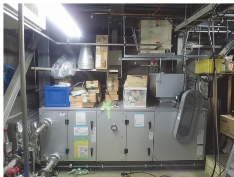
写真Ⅲ.4.1.3-6 管理棟 新設外調機
