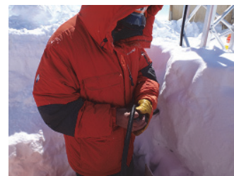
写真Ⅱ.2.4.2.1-15 ケーブル保護チューブ補修
