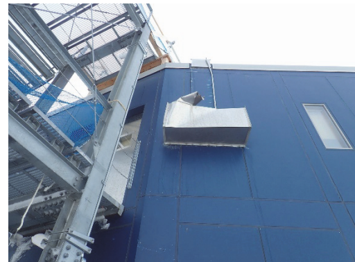
写真Ⅲ.4.1.3-10 外気ダクト破断の様子
