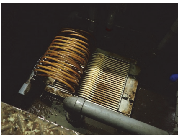
写真Ⅲ. 4. 7. 1-1 (左) 曝気槽水位を下げ、膜ユニット上部を露出させる。
