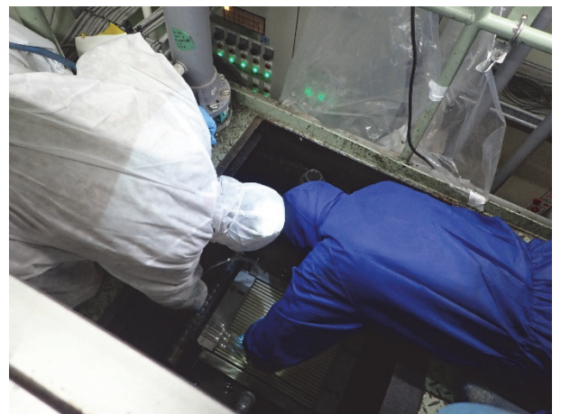
写真Ⅲ.4.7.1-6 もう一方も同じように膜を交換
