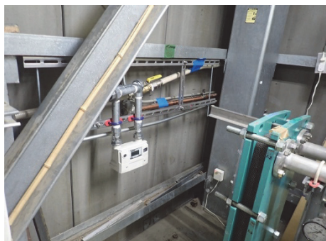
写真Ⅲ.4.1.3-22 管理棟 ガスマイコンメーター
