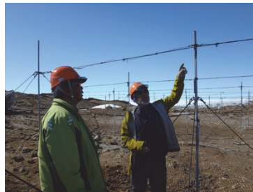
図Ⅱ.2.3.1.8-1 (左) アンテナ支線の確認・交換作業の様子
