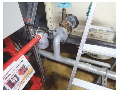
写真Ⅲ.4.1.3-29 消火配管漏水の様子
