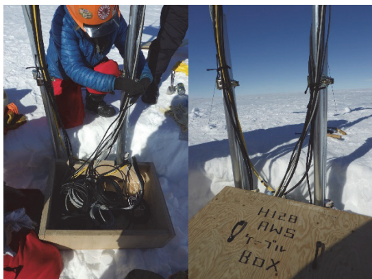
(ケーブルボックスへのケーブルの収納)
