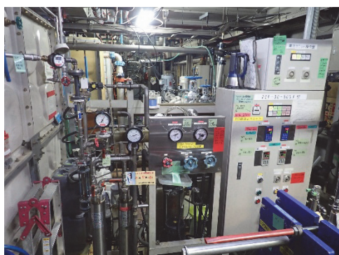
写真Ⅲ.4.1.3-14 発電棟 造水装置
