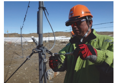
図Ⅱ.2.3.1.8-1 (左) アンテナ支線の確認・交換作業の様子
