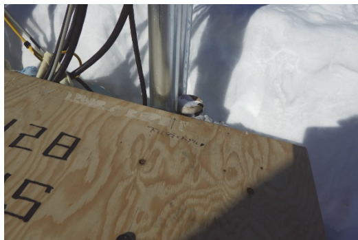
(ケーブルボックスへのケーブルの収納)
