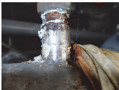
写真Ⅲ.4.1.3-1 温水配管漏水の様子
