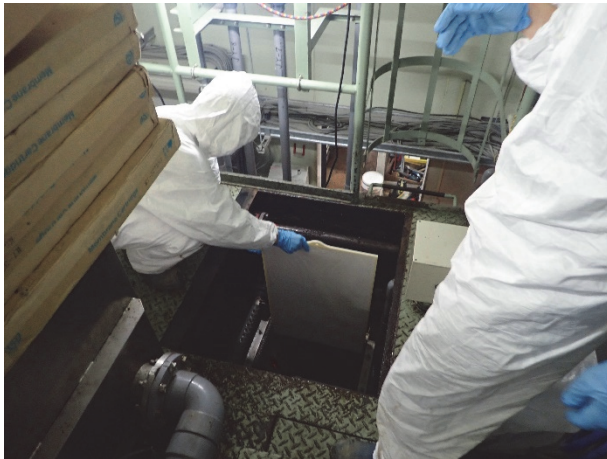
写真Ⅲ.4.7.1-3 新しい汚水膜を挿入する。
