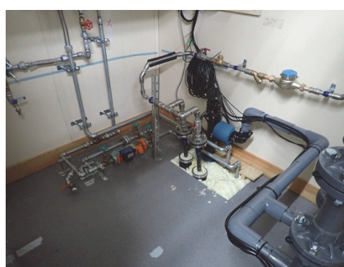
写真Ⅲ.4.1.3-25 機械室床開口塞ぎの様子
