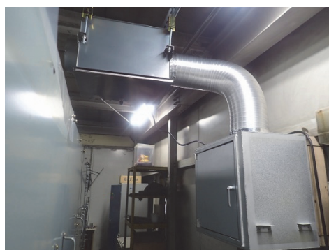
写真Ⅲ.4.1.3-4 制御室 新設ファン設置
