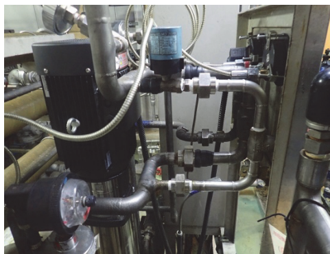
写真Ⅲ.4.1.3-17 新設高圧ポンプ
