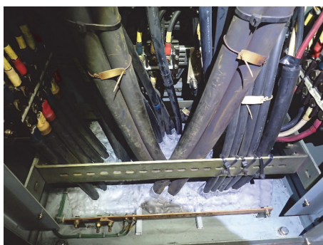
写真Ⅲ.4.1.2-2 盤内開口部パテ埋め作業後
