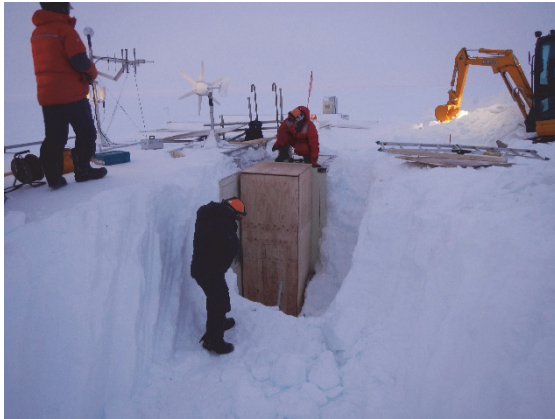
図Ⅲ. 4. 1. 7－1 機械室側入り口設置中
