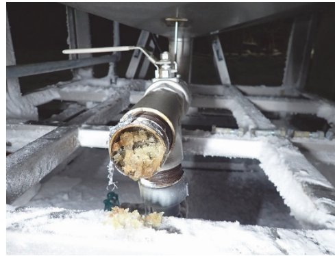
写真Ⅲ.4.1.3-12 燃料配管内凍結の様子
