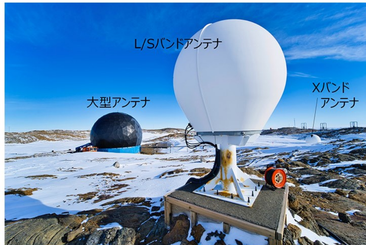
大型衛星受信アンテナとL/S/Xバンド衛星受信アンテナの配置 (撮影：JARE61 落合哲)
