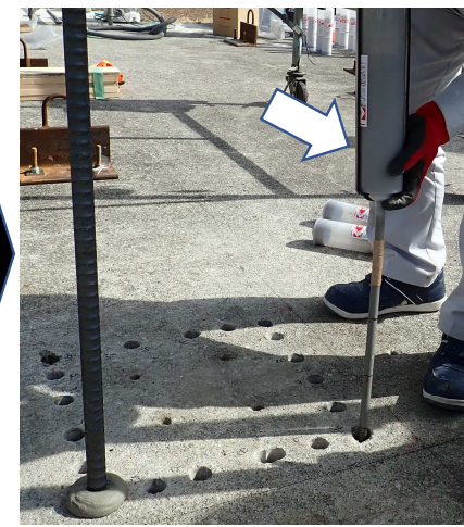
セメフォース アンカー注入
