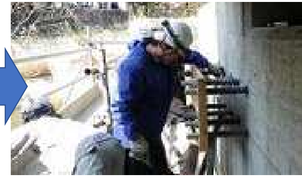
アンカー筋挿入・定着
