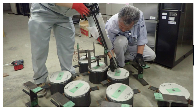
セメフォースアンカー注入
