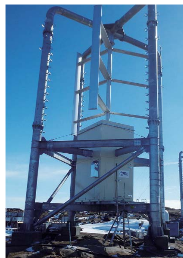
昭和基地に設置された20kw風力発電機
