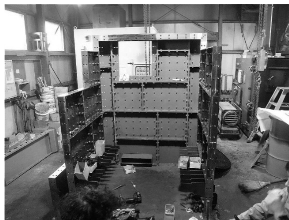
写真Ⅲ.4.5.5-2 一次燃焼室壁側面組立て(3/22)
