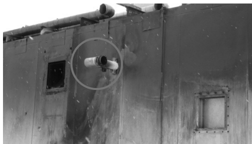
写真Ⅲ.3.3.1.1-1 工事前(左)、工事後(右)の小型発電機小屋の排煙ダクト
