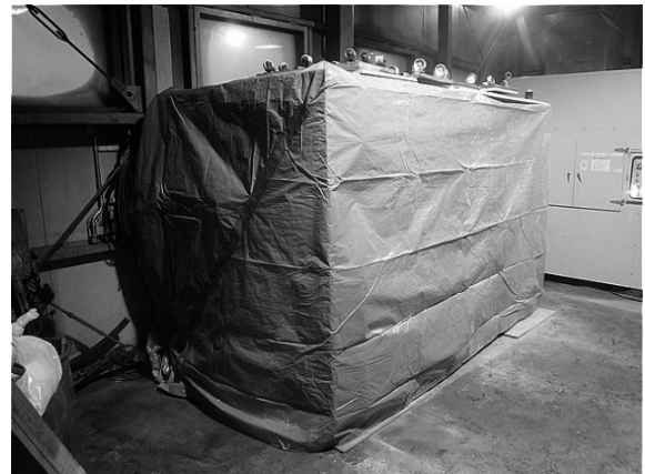
写真Ⅲ. 4. 5. 5-14 ブルーシート遮蔽保管 (6/14)
