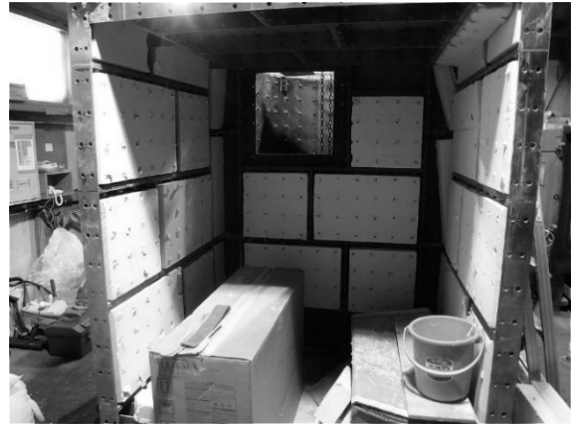
写真Ⅲ. 4. 5. 5-4 一次燃焼室石膏ボード組込み (3/31)
