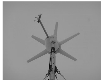
図 II 2.2.1.1-2 破損した風力発電機
