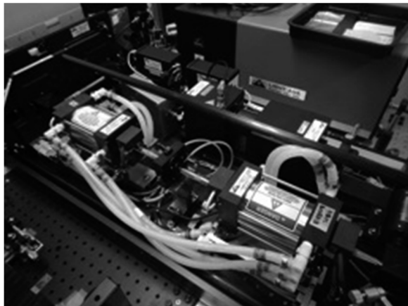
写真 II. 2.1.1.2-1 クリーンブース内に設置されたレーザーヘッド内部の光学素子。
