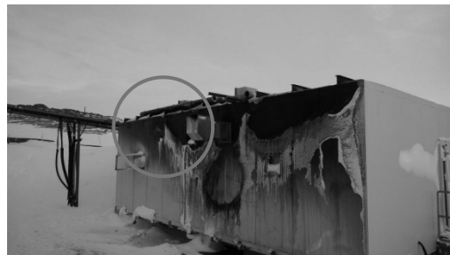
写真Ⅲ.3.3.1.1-1 工事前(左)、工事後(右)の小型発電機小屋の排煙ダクト
