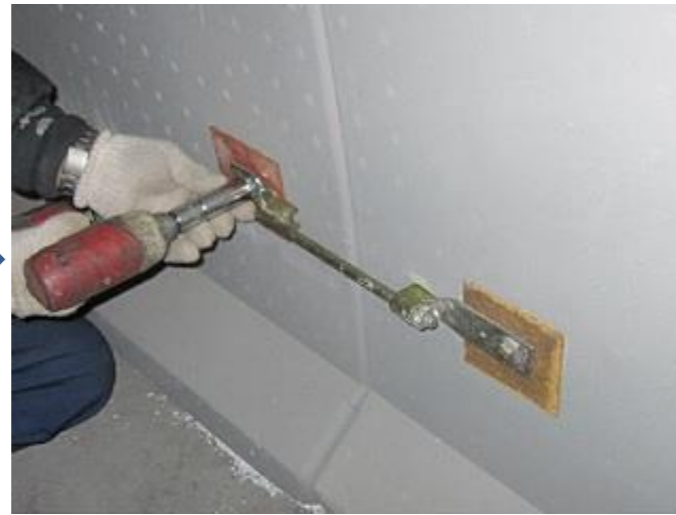
ドームピース圧着状況
