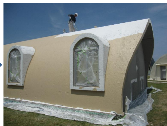
外装工事状況
