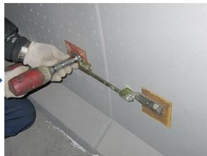
ドームピース圧着状況
