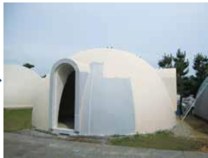
外装工事状況
