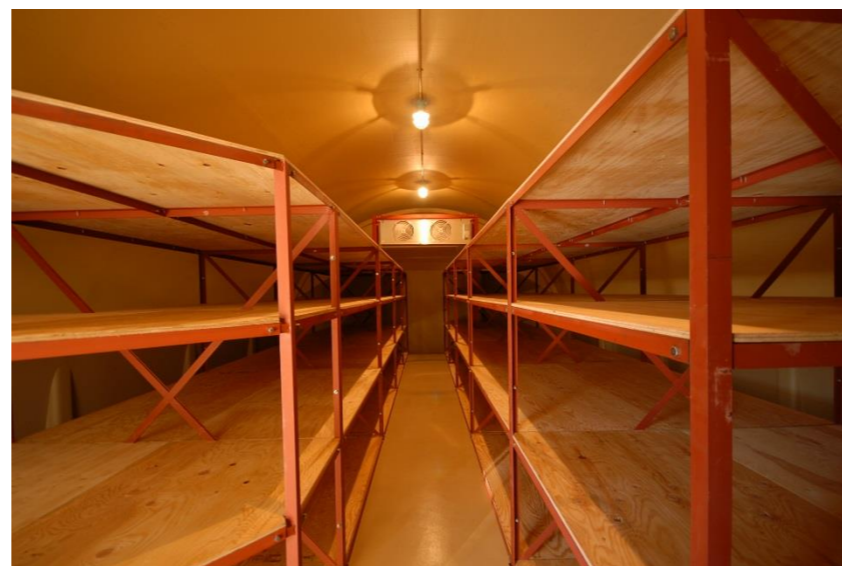
冷凍倉庫内観
