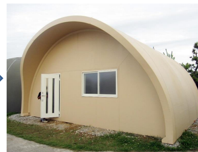
施工完了 (外観)
