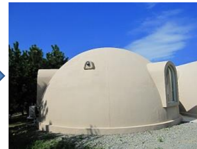
施工完了 (外観)
