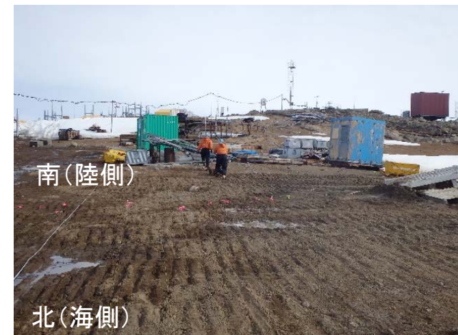
地中探査レーダでのデータ取得作業
