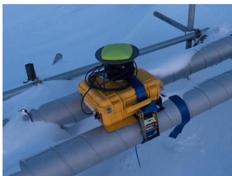
設置後測量用GPSにて位置情報の 測定を行う(約24時間)
