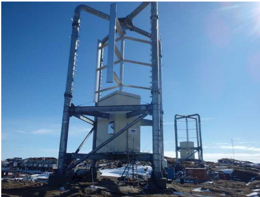
垂直軸風車：昭和基地の20kW風車（56次隊中村隊員提供）
