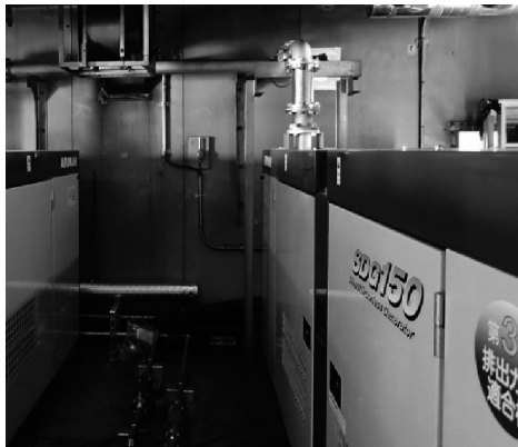
図Ⅲ.3.3.1.1-3 排ガス配管工事前(左)、後(右)の小型発電機小屋の状態
