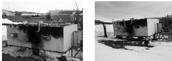
図Ⅱ.2.1.1.1-1 小型発電機小屋除雪前（左）及び除雪後（右）の様子
