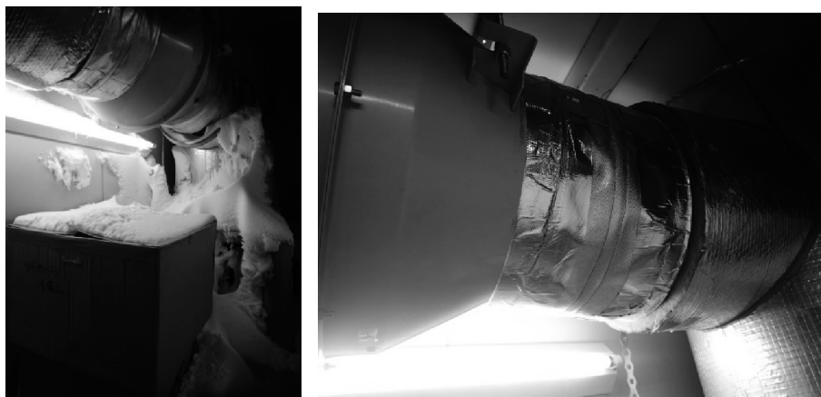
図 III. 3. 3. 1. 1-1 機械室ダクトカバー補修前(左)、後(右)の状態
