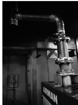
図Ⅲ.3.3.1.1-3 排ガス配管工事前(左)、後(右)の小型発電機小屋の状態
