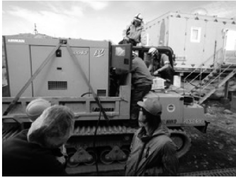
写真Ⅱ.2.1.1.2-4 (左)光学観測棟の物資搬入扉側に仮設置された予備発電機SDG45(右)レーザーの使用電力等のデータ記録のために接続されたクランプメータ。
