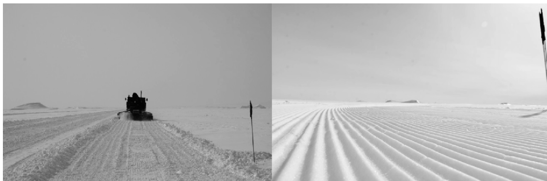
写真Ⅲ.5.4.1-4 ピステンによる整備風景とミルかけをした雪面状況
