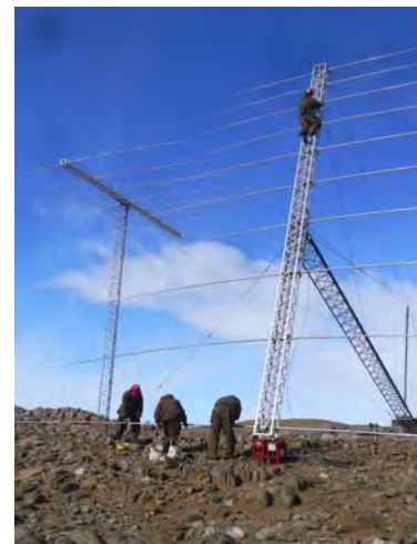
昭和基地SuperDARNレーダーアンテナの保守作業
