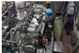
ディーゼルエンジンは6気筒23,000cc、(最大出力300kVA (約240kw)、電圧400V、周波数50Hz)。
