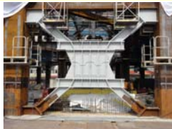
せん断パネル型 新合金制振ダンパー
