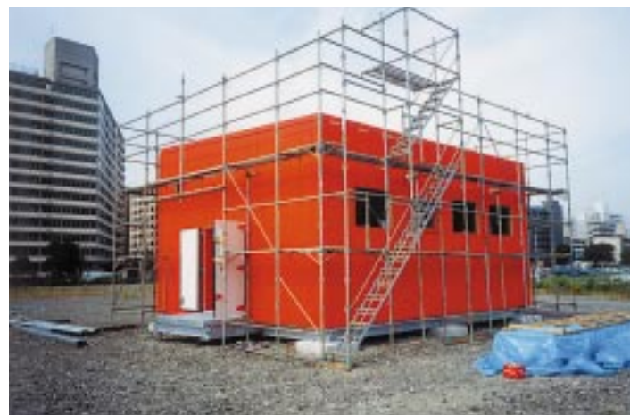
焼却炉棟の仮組立
