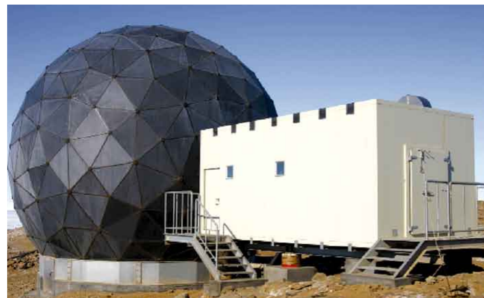
45次隊夏作業で完成した高速衛星通信システムのアンテナドーム(左の黒い球体)と送受信系を収納するシエルター(右手の小屋)
