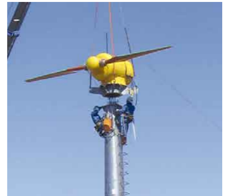
風力発電装置工事の様相
