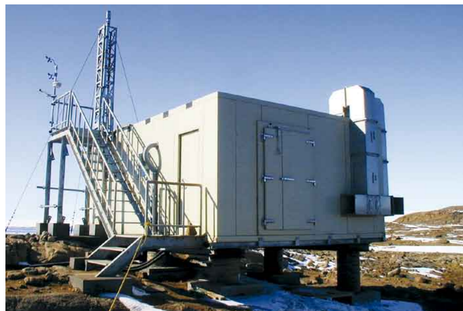
第45次隊により建設されたエアロゾル観測小屋
