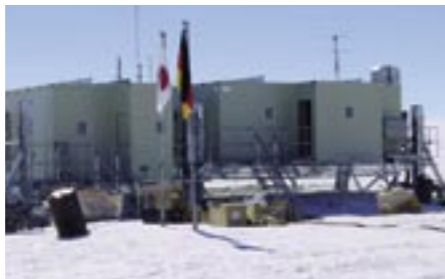
ジャッキアップ方式の建物（発電小屋と食堂小屋）
