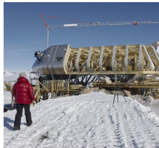
建設中の基地主屋
