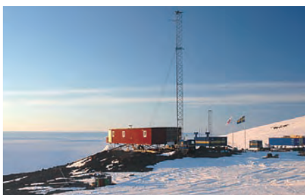
ワサ基地の居住棟。資材用コンテナと雪上車の格納庫が右側に並ぶ。
