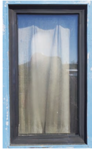
図 3 観測棟の開口部
