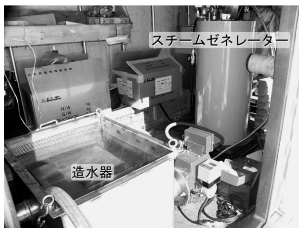
図2 専用幌機内に設置されたスチームドリル。左から、造水装置、給水ポンプ、スチームゼネレーター
