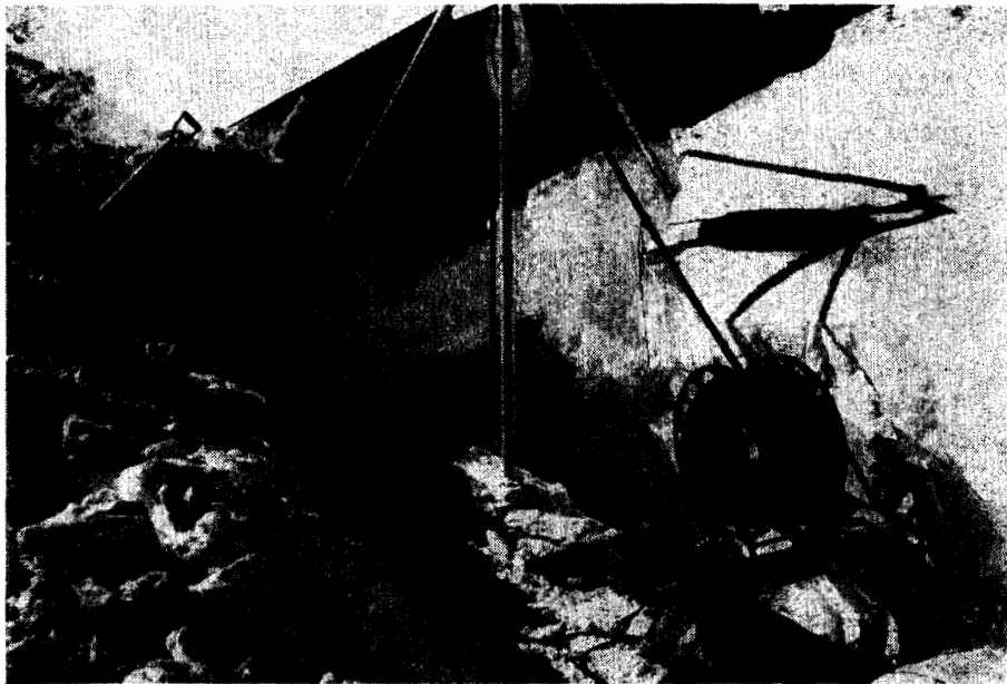
図 6 排水孔の掘削現場
