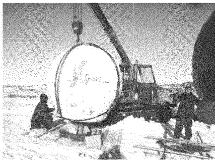
写真Ⅲ.2.5.6.1-1 アンテナ台座交換
