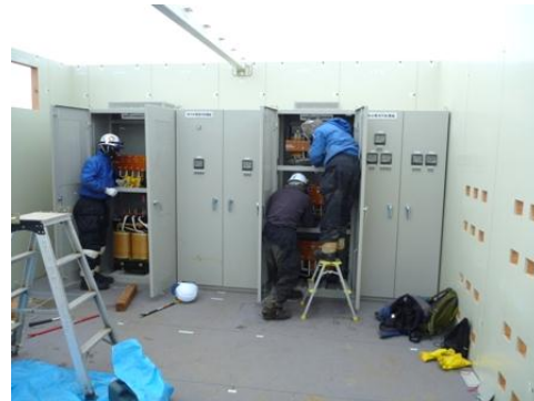
写真Ⅲ. 4. 1. 5-2 分電盤内トランス設置
