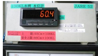
写真Ⅲ. 4. 1. 41-2 制御室に設置した表示器
