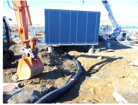
写真Ⅲ.4.1.5-4 幹線ケーブル道路横断部分
