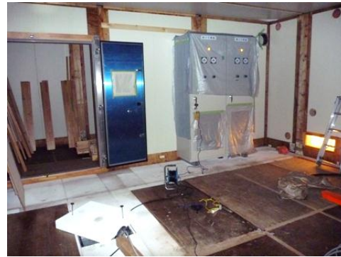
写真Ⅲ. 4. 1. 2-2 分電盤設置後
