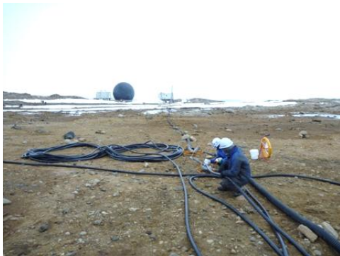
写真Ⅲ. 4. 1. 5-1 基地電源幹線引き
