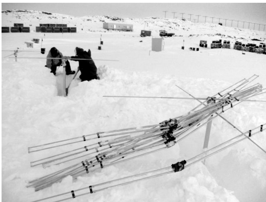
写真Ⅲ. 3. 1. 1. 3-1 積雪で埋もれたアンテナエレメントの掘り出し作業の様子
