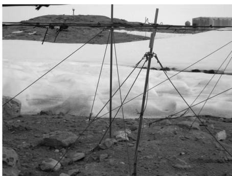
写真Ⅲ.3.3.1.3-1 曲がった支柱の例
