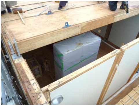
写真Ⅲ. 4. 1. 2-1 分電盤取り込み
