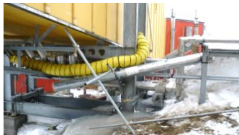
写真Ⅲ.4.1.35-4 配管群西側ダクトと 通路棟南壁面用フレキシブルダクト
