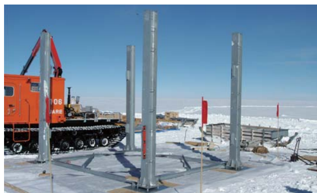
ドームふじでの圧雪地盤基礎造成の現地実験
