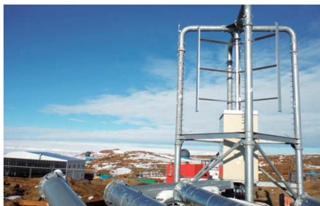
昭和基地でディーゼルとの連系運転を始めた20kW風車
