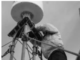
ケーブル保護管取付作業
