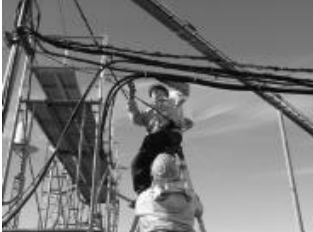
架空ケーブル配線にも足場設置 足場施工は稼働が掛るため脚立も利用 ケーブルを屋内引込中
