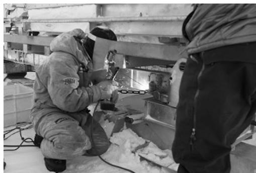
写真Ⅲ. 7. 4. 1-14 補修溶接
