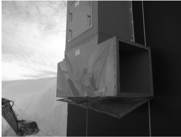
写真Ⅲ. 3. 3. 1. 2-1 破損した PANSY 小屋吸気ダクト
