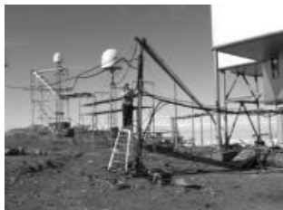
架空ケーブル配線にも足場設置 足場施工は稼働が掛るため脚立も利用 ケーブルを屋内引込中
