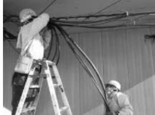
架空ケーブル配線にも足場設置 足場施工は稼働が掛るため脚立も利用 ケーブルを屋内引込中
