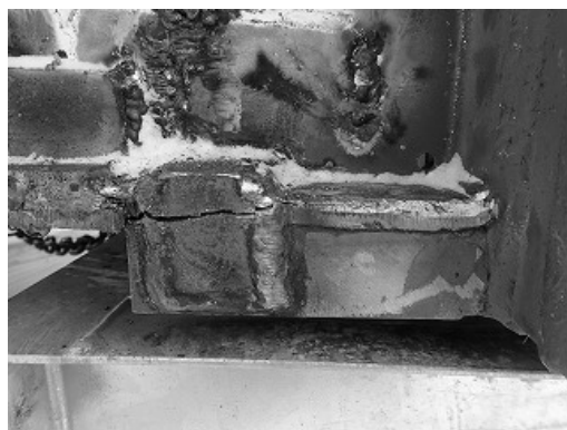
写真Ⅲ. 7. 4. 1-16 補強鋼材損傷状況
