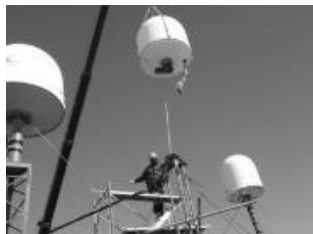
撤去/設置にはクレーン必須
