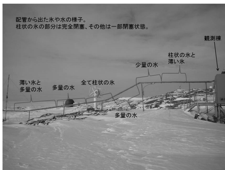
写真Ⅲ.3.2.3.1.2-1 インレットからの配管ライン閉塞状況
