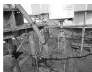
曲部に対して保護管設置
